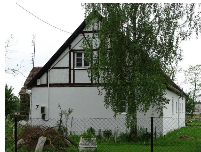
Widok ogólny od pół.-zachodu
