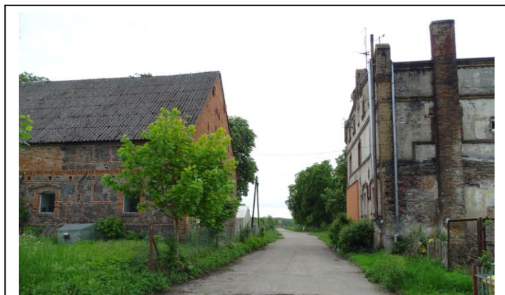
Północna część podwórza folwarcznego
