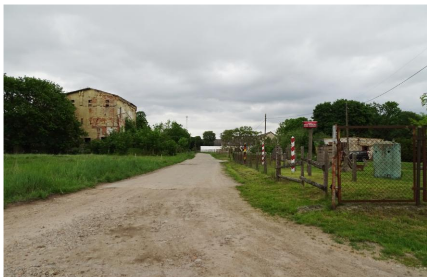
Podwórze folwarczne – widok od południa
