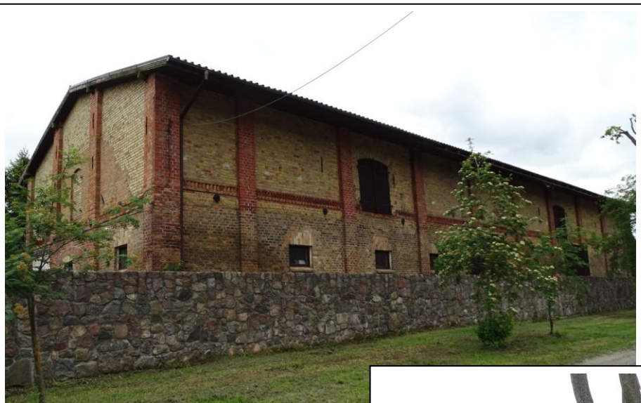
Widok ogólny od płn.-zachodu
