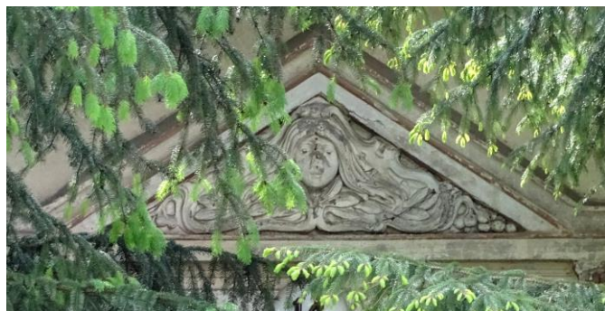
Detal nad drzwiami frontowymi
