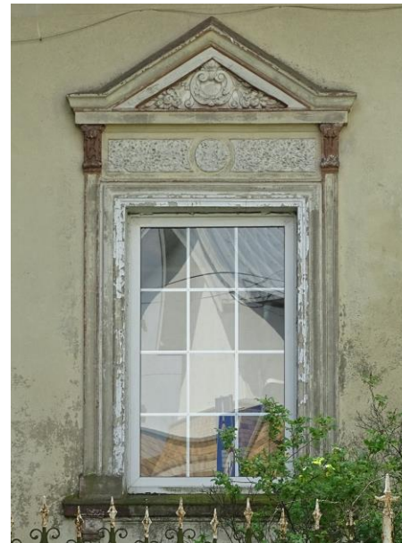
Okno w elewacji frontowej
