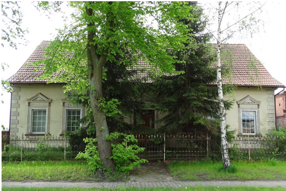
Elewacja frontowa - północna
