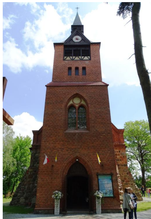
Wieża – widok od zachodu
