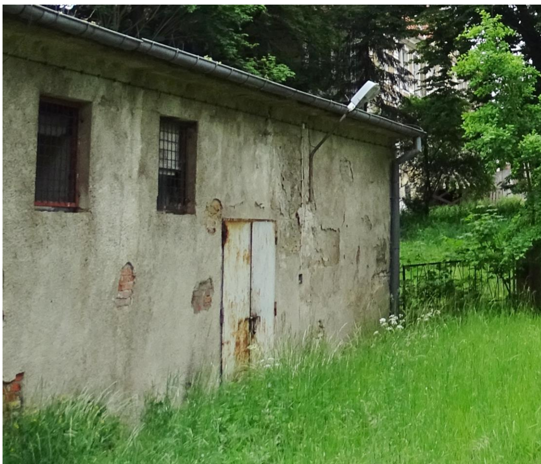
Widok ogólny od wschodu
