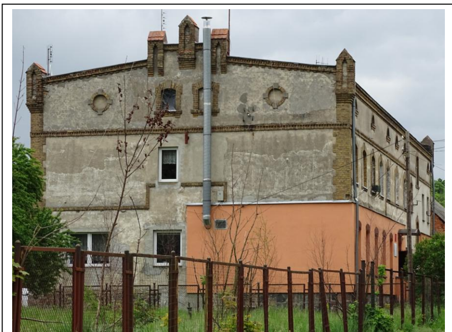
Elewacja szczytowa zachodnia
