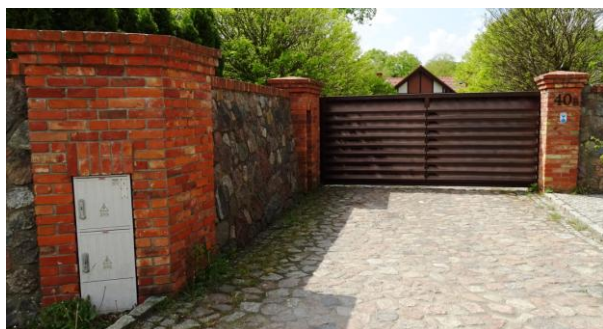
Ogrodzenie i brama wjazdowa
