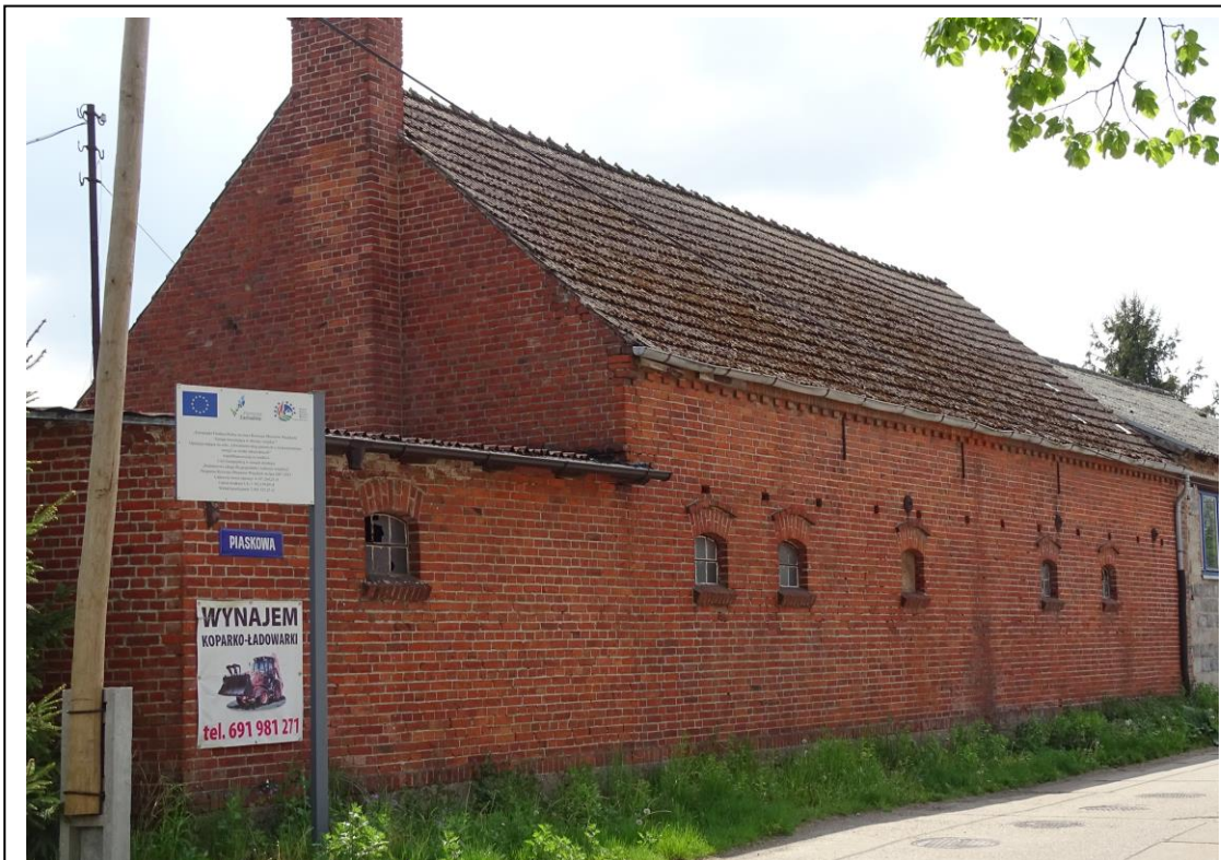
Widok ogólny od płn.-zachodu
