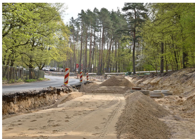
Węzeł Głębokie – trwają intensywne prace
