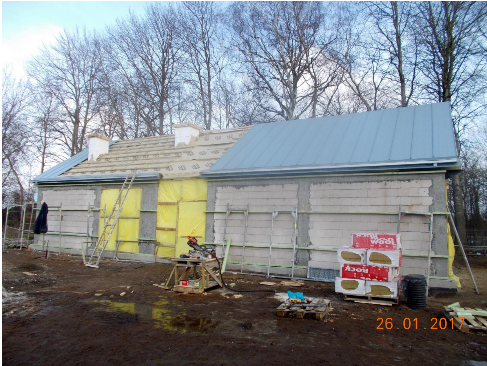
Budynek światlicy środowiskowej w Łęgach
